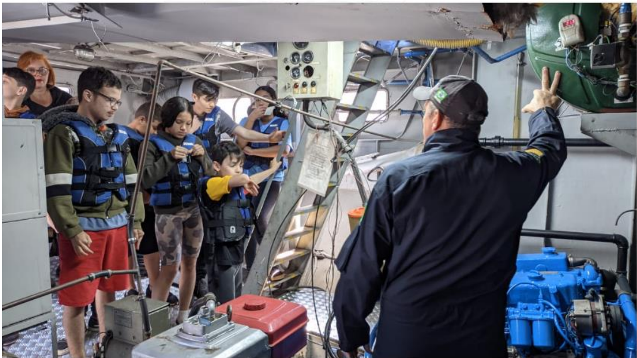
Figura 2: Encarregado da AgEFlut e escoteiros do Mar na praça de máquinas do navio.
